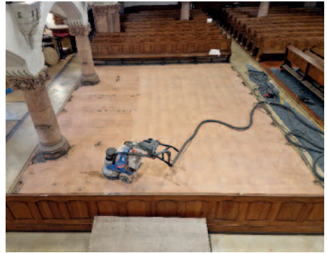
Fußboden abschleifen
